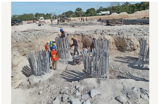
Trabajos en elementos de cimentación profunda.
