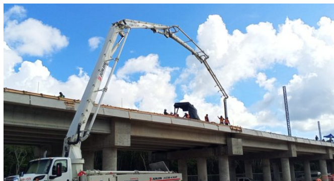
Colado de superestructura con bombeo de concreto.
